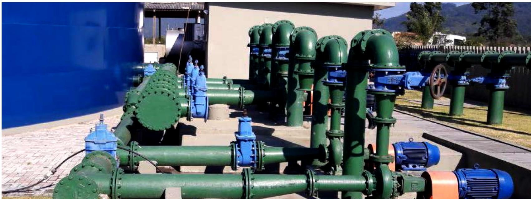
**Sistema Morretes:** Foi completamente implantado pela **CONASA - Águas de Itapema**. Não existia até 2004. Conta com estações elevatórias tanto de água bruta quanto de água tratada. Na lagoa de acumulação de água bruta, a jusante há o Rio Perequê e a montante a ETA Morretes. Já o sistema de recalque de água tratada conta com seis conjuntos moto-bomba dotados dos respectivos inversores de frequência.
