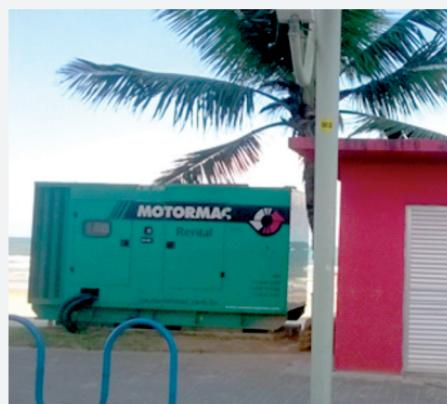
Para garantia do funcionamento de todas as unidades operacionais, mesmo na ausência de energia elétrica, o que é comum no verão, a Conasa Águas de Itapema instalou 17 geradores de energia elétrica, contemplando todas as elevatórias e a Estação de Tratamento de Esgoto, além de todas as unidades operacionais do sistema de abastecimento de água.
