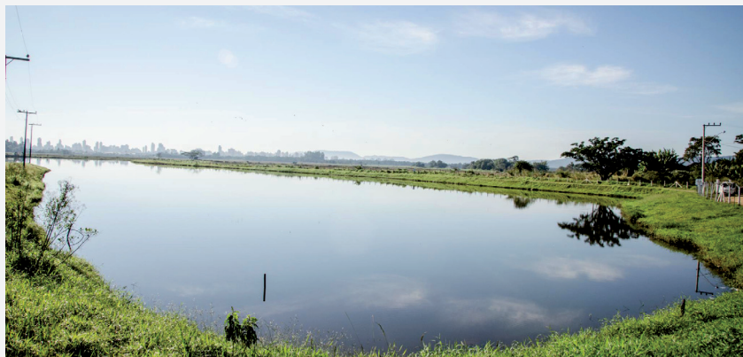
Lagoa de reservação
