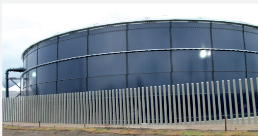
Um dos grandes reservatórios de água localizado na ETA Morretes
