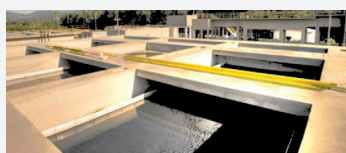
Tratamento do esgoto na ETE Morretes
