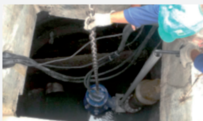
Instalação das novas bombas da EEE 205
