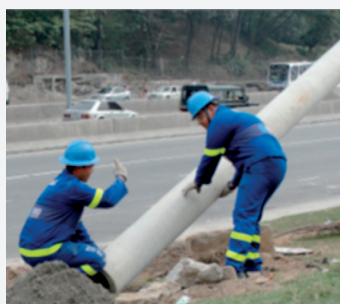
Equipes de Construção
