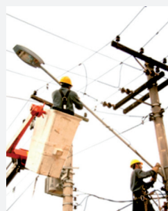
Equipes de Manutenção
